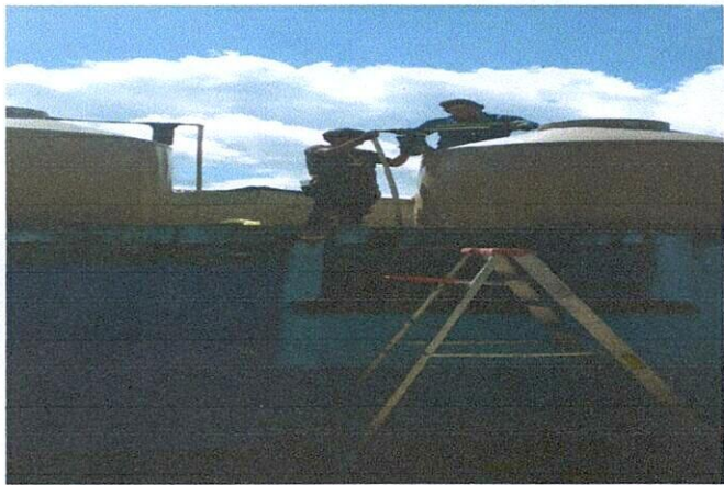
Foto 1: MEJORAMIENTO DE ÁREA DE SERVICIOS SANITARIOS
