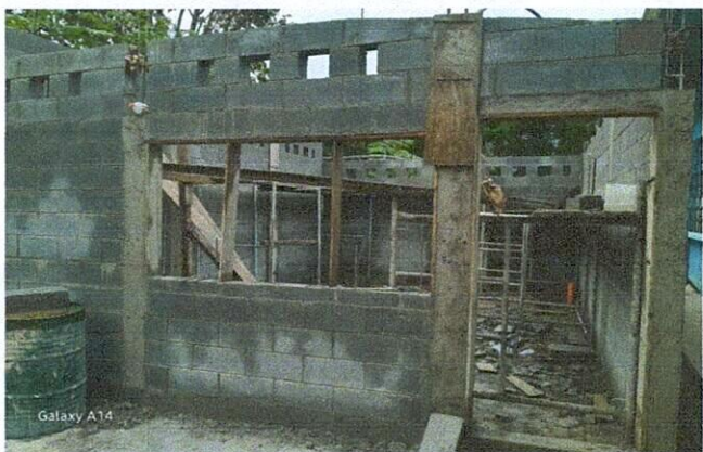
Foto 3: REPARACIÓN O SUSTITUCIÓN DE MÓDULO DE COCINA
